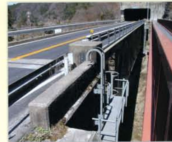
中津川市内国道19号 鋼トラス橋路面部
