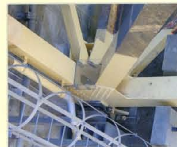
桁端部のカバー施工
