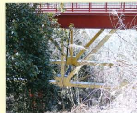
中津川市内国道19号 鋼トラス橋(上落式)側面
