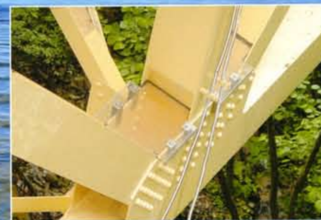
トラス格点カバー設置
