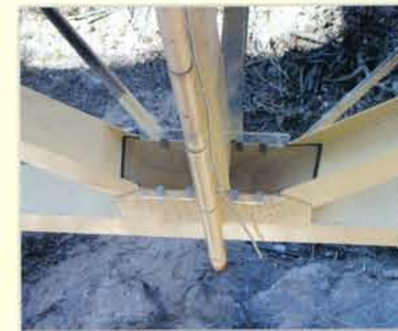
中央部のカバー施工
